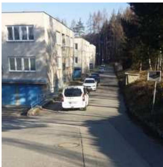
Obr 12: poslední část, na pravé straně koryto s betonovými žlaby
