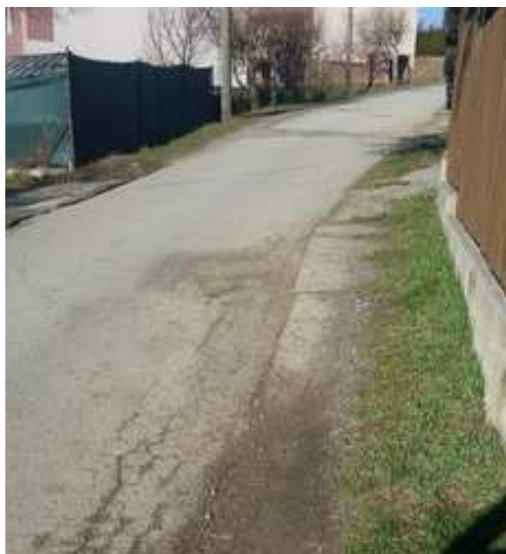
Obr 15: betonové panely, které budou odstraněny
